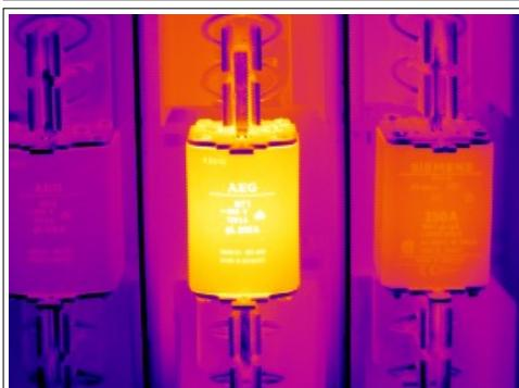
Este termograma nos revela la diferencia de fusibles, esto puede terminar con la salida de servicio imprevista e innecesaria por falta de una fase, sin pensar en todos los problemas mayores que esto puede causar.
